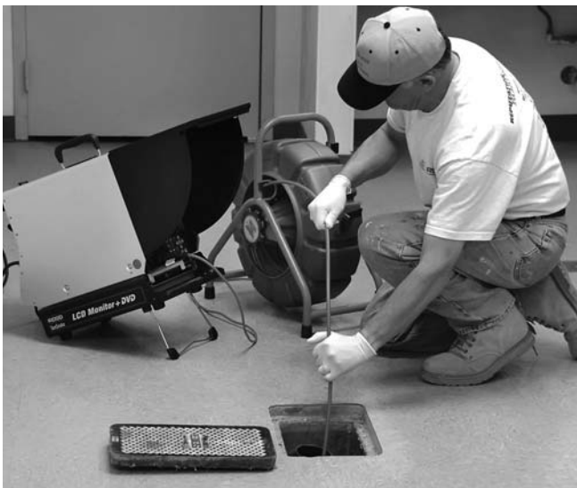
Figure 28 – Bonne technique de poussée du câble
